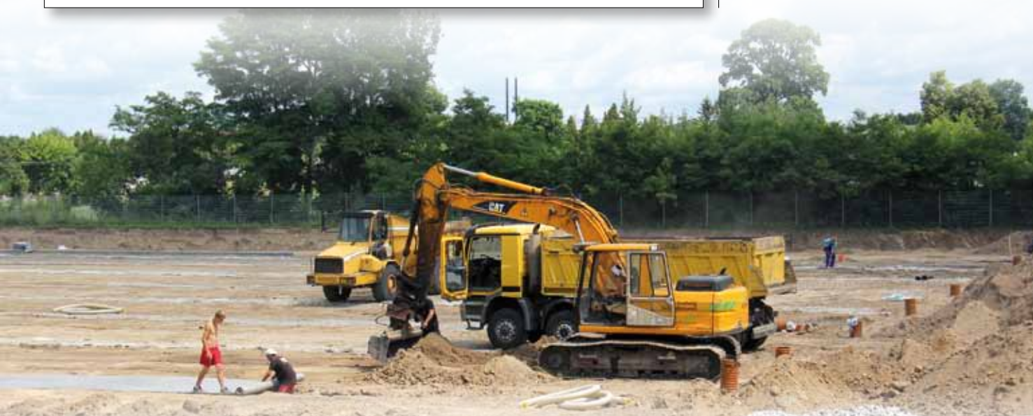
Budowa stadionu przy ul. Budowlanej
