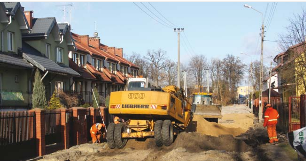
Przebudowa ul. Widok
