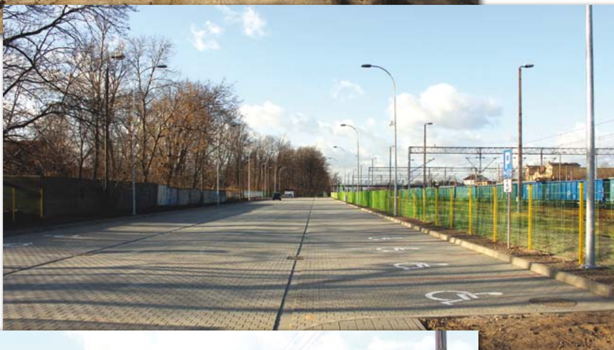
Parking w systemie „Parkuj i jedź”
