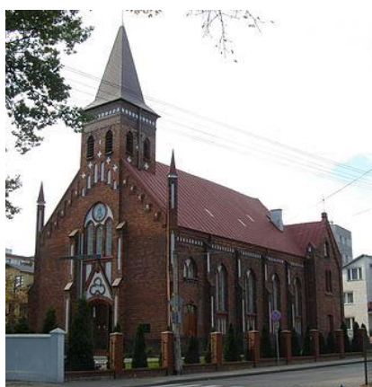
Budynek Kościoła Starokatolickiego Mariawitów przy ul. Traugutta 17 w Mińsku Mazowieckim – widok współczesny
