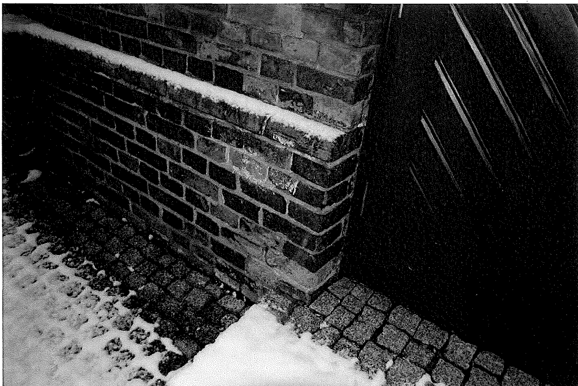
Fotografia nr 14. Ściana zewnętrzna przy wejściu do pomieszczenia 1.03 Kaplica.
