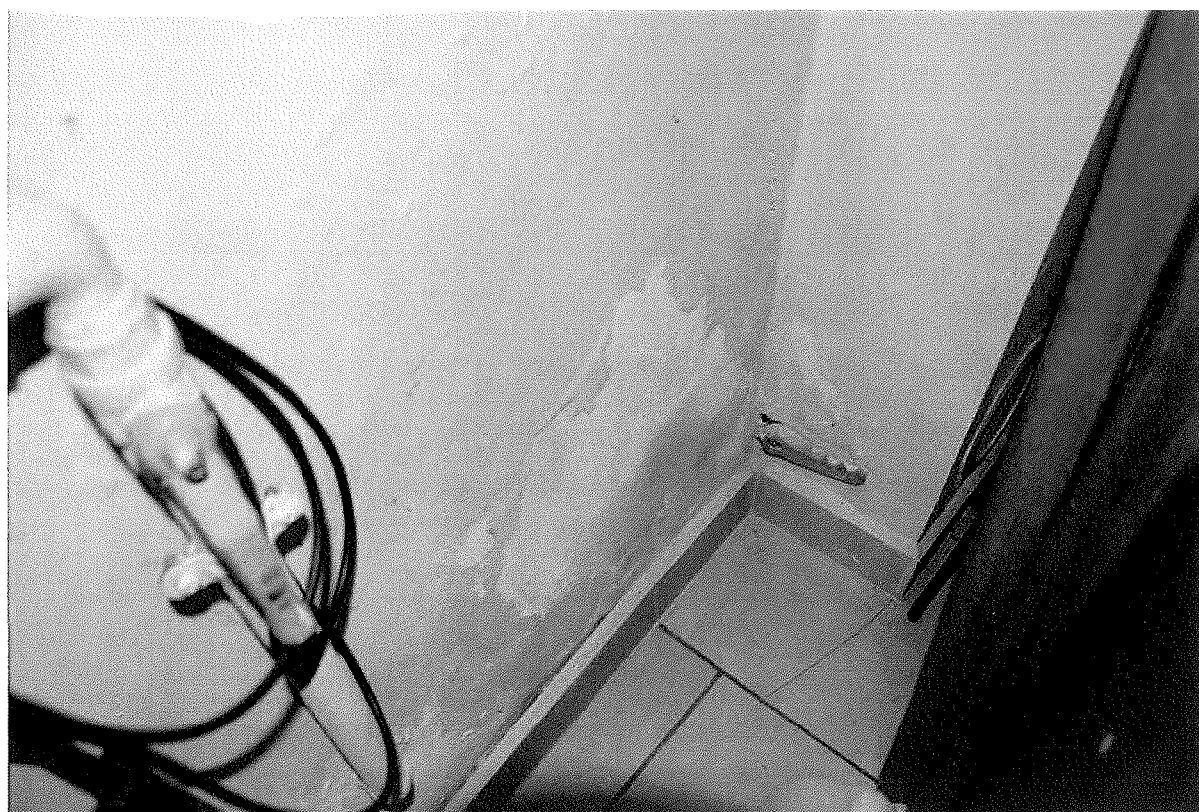
Fotografia nr 4. Ściana wewnętrzna pomieszczenia 1.02 Zakrystia
