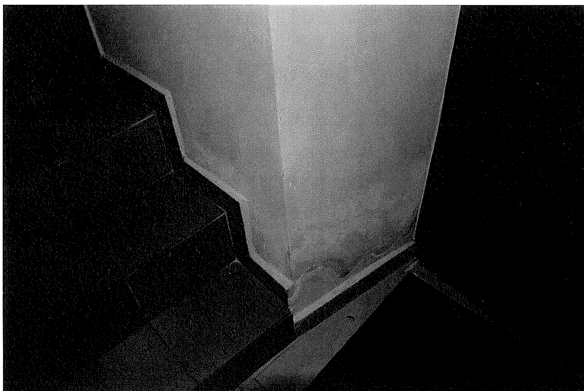
Fotografia nr 8. Wnęka drzwiowa pomieszczenia 1.01 Komunikacja.
