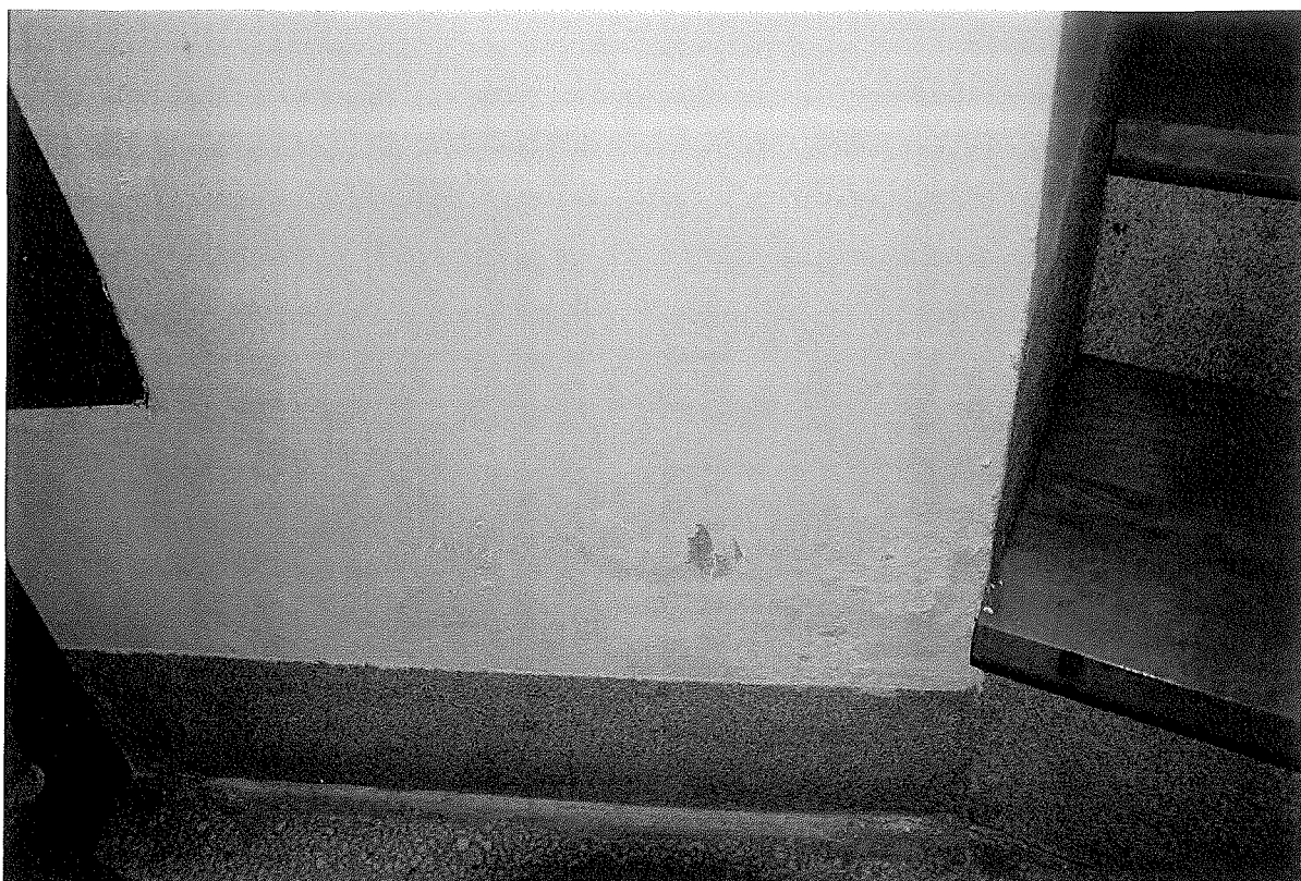
Fotografia nr 3. Wnęka wejściowa przy głównych drzwiach wejściowych
