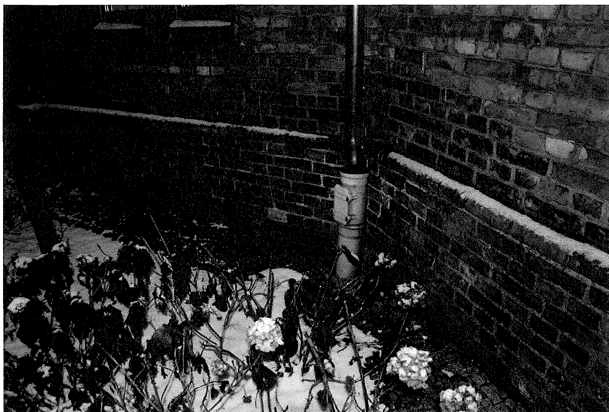
Fotografia nr 12. Ściana zewnętrzna pomieszczenia 1.03 Zakrystia.
