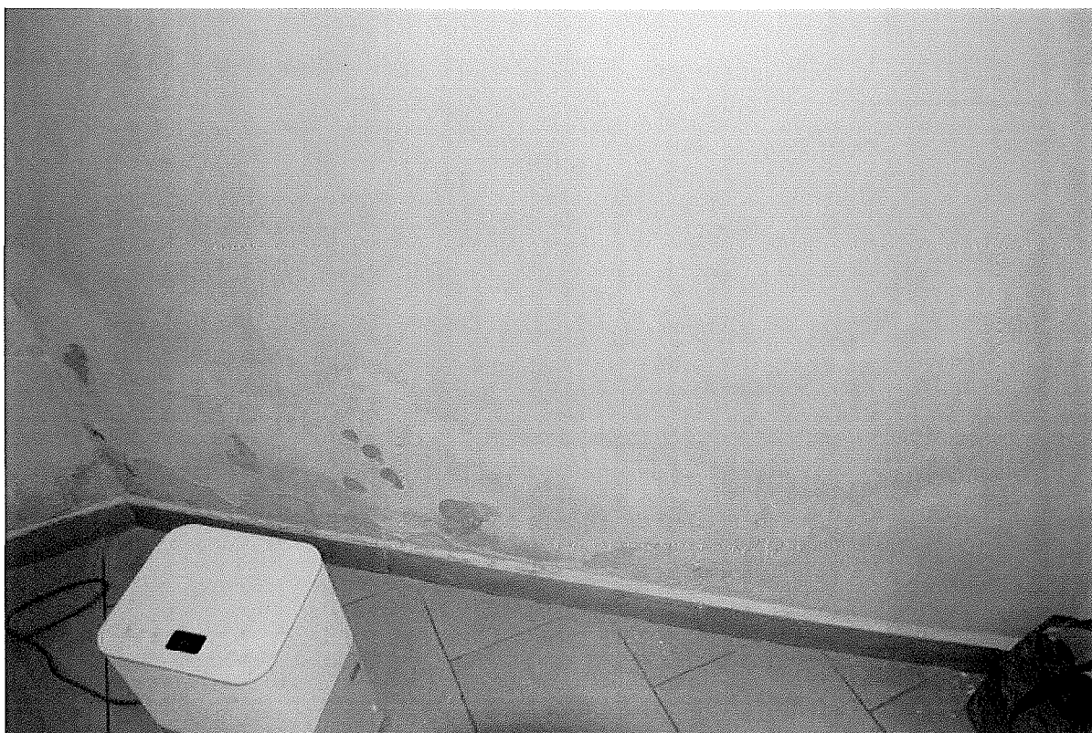
Fotografia nr 6. Ściana wewnętrzna pomieszczenia 1.01 Komunikacja
