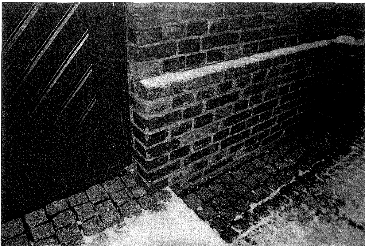
Fotografia nr 13. Ściana zewnętrzna przy wejściu do kaplicy.
