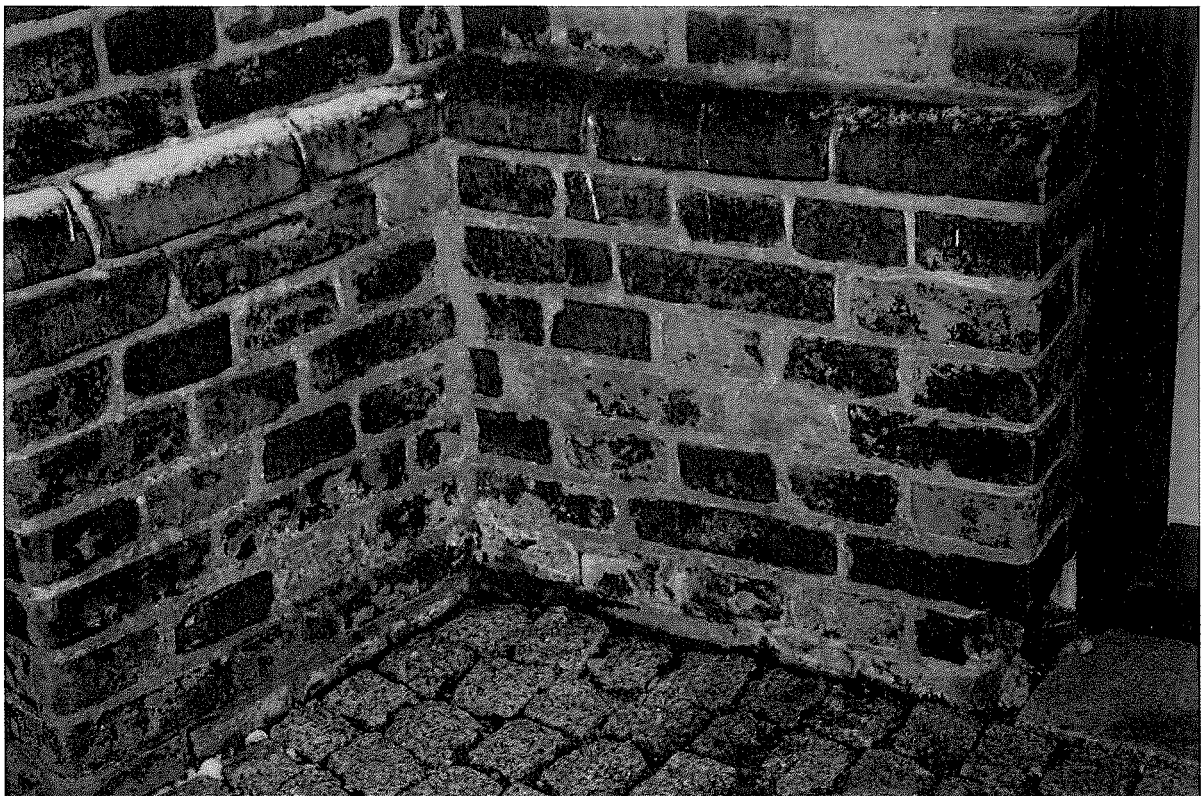
Fotografia nr 10. Ściana zewnętrzna przy wejściu tylnym .
