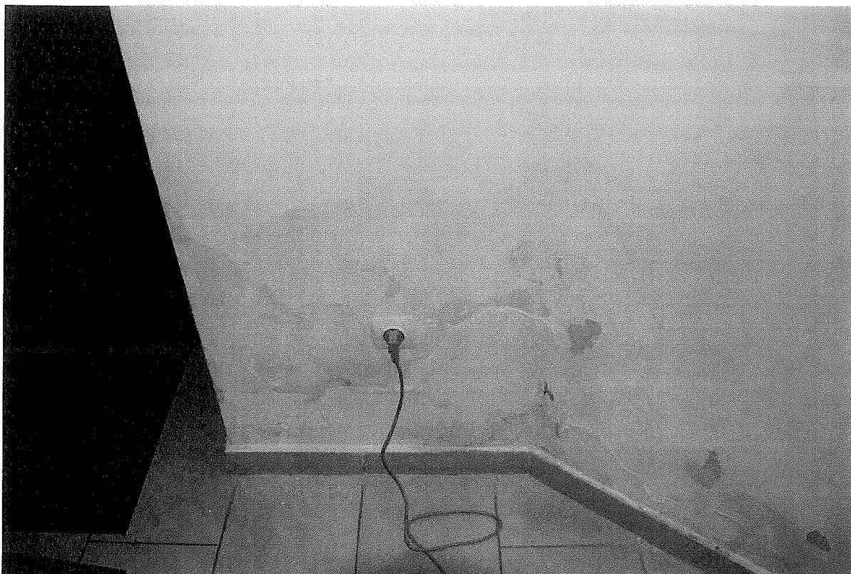
Fotografia nr 7. Ściana wewnętrzna pomieszczenia 1.01 Komunikacja
